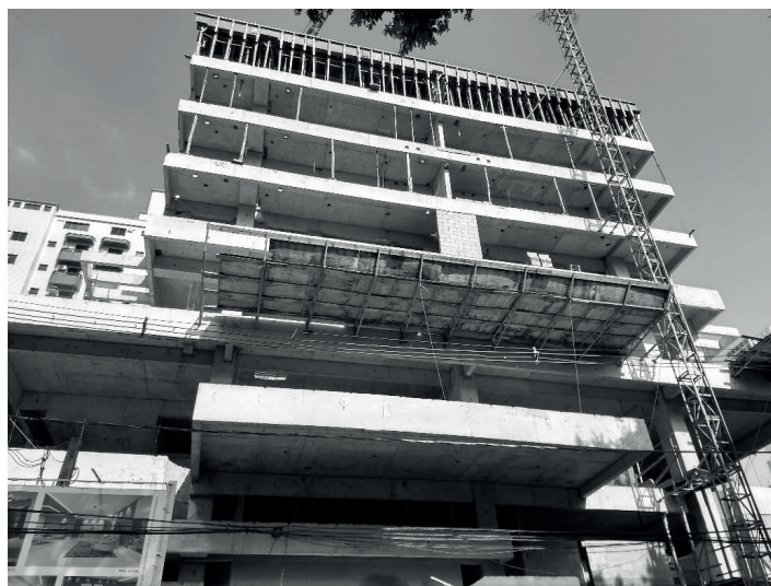
Figura 6 - Coral Residence em construção na rua Colômbia
