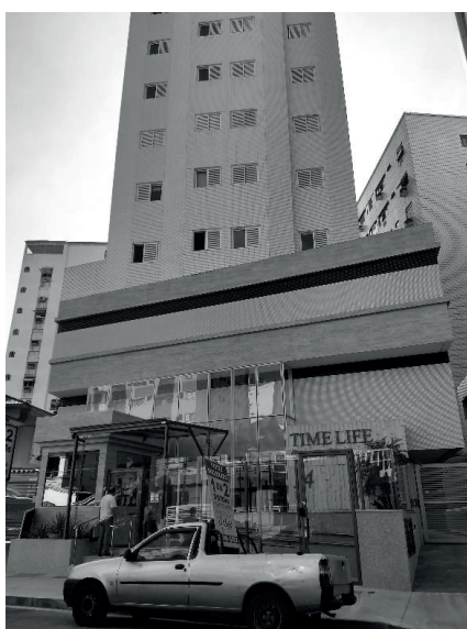
Figura 18 - Edifício Rua Colômbia
