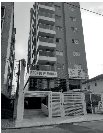
Figura 17 - Edifício na rua Dr. Vitor de Lamare
