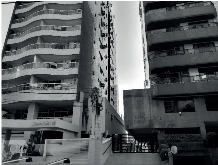
Figura 9 – Embasamento edifícios Rua Dr. Clóvis Beviláqua
