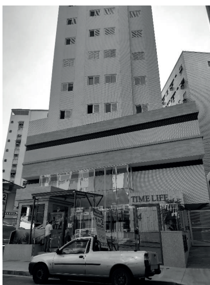
Figura 18 - Edifício Rua Colômbia
